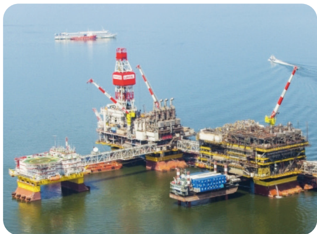
МЛСП им. Владимира Филановского. Пожарные шкафы, система дозирования пенообразователя. Заказчик: ЛУКОЙЛ
