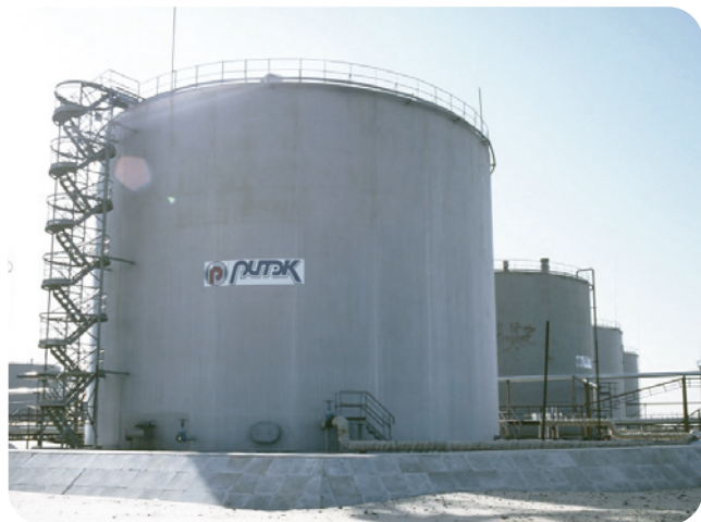
Резервуарный парк Сандибинского месторождения. Установки пенного пожаротушения, пожарное оборудование. Заказчик: ТЕХЦЕНТР «ЛУКОМ-А» (РИТЭК, ЛУКОЙЛ)
