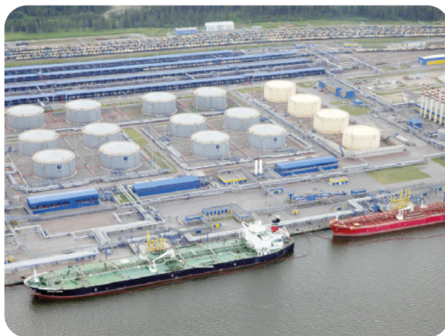
Морской терминал НОВАТЭК Усть-Луга. Системы дозирования, генераторы пены, лафетные стволы, вышки. Заказчик: НОВАТЭК
