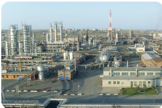
Орский НПЗ. Комплексы пожарного оборудования. Заказчик: Электроснабсбыт, Орскнефтеоргсинтез
