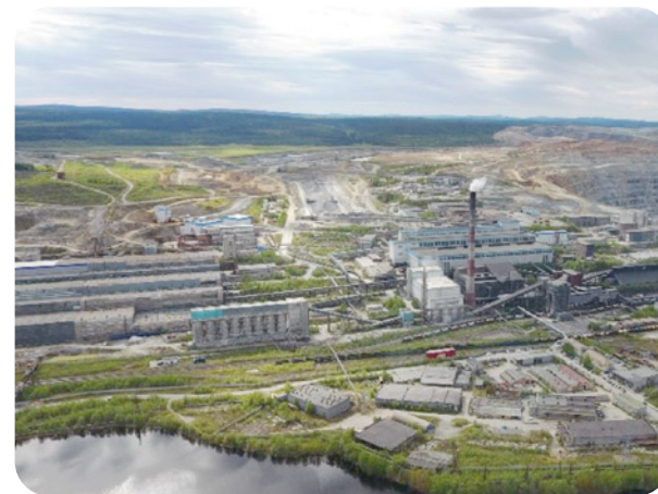
Ковдорский ГОК. Комплексы пожарного оборудования. Заказчик: АЭС – Торговый дом
