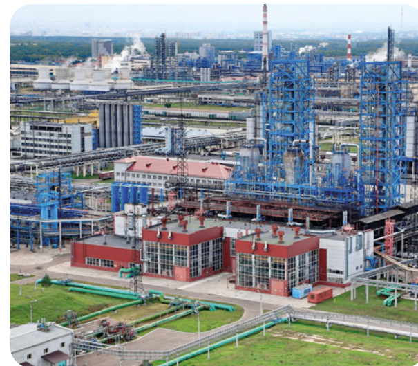
Завод «Этилен». Блок-контейнер для пенного пожаротушения, пожарное оборудование. Заказчик: КазаньОргСинтез
