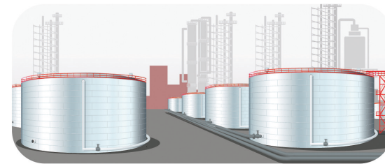
Резервуары с нефтью и нефтепродуктами
